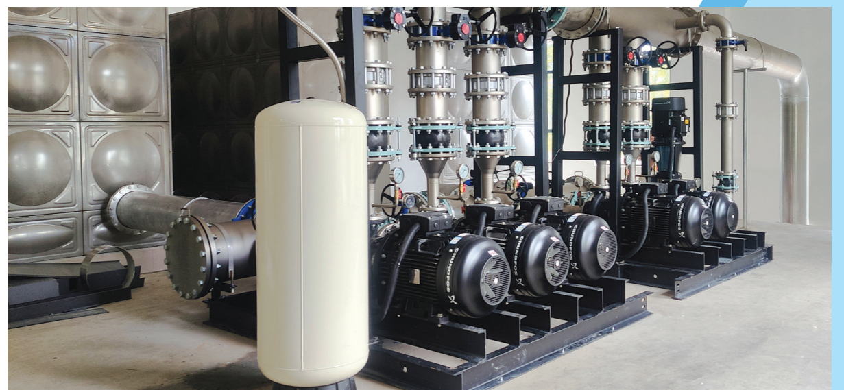
▲ 浙江大型万人农场泵房改造项目选择格兰富定制预装式智能供水机组
